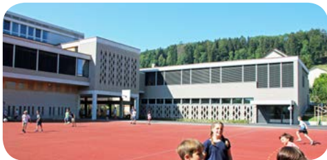
Pünt mit Erweiterungsbau über der Schwimmhalle
